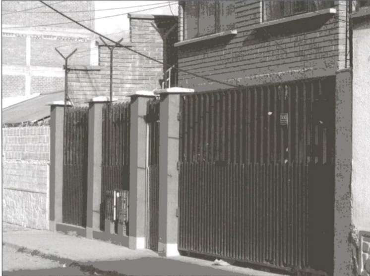
Los vecinos de Ciudad Satélite recurren a la autoprotección, que va desde elevar el muro de la casa hasta colocar alambres de púas y vidrios. Foto: Equipo de investigación.
