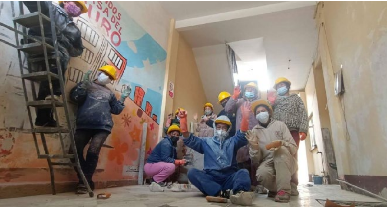
Imagen: Mujeres constructoras transformando con sus manos un espacio. Después de demoler y reutilizar materiales, remodelan el lugar con color, cuidado y dándole vida. (Fuente: Reyna Madeley 2025)
