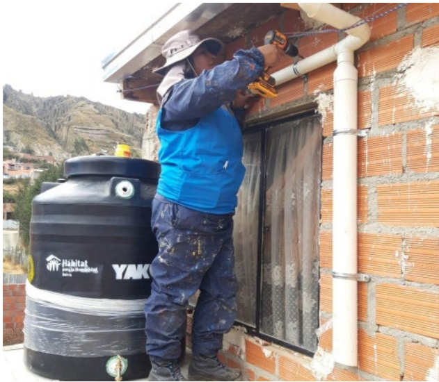
Imagen: Instalación de cosecha de agua pluvial con el proyecto Yaku, para reciclar y cuidar cada gota. Mujeres construyendo soluciones sostenibles desde el territorio. (Fuente: Reyna Madeley 2025)
