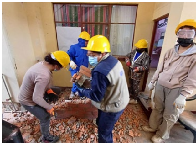
Imagen: Realizando la demolición de un espacio y seleccionando el material para reutilizar. (Fuente: Reyna Madeley 2025)
